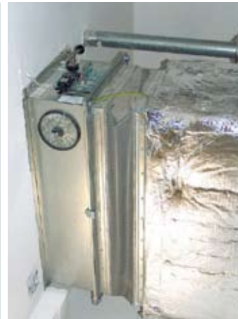
Bild 5: Einbau einer Brandschutzklappe FK90 in eine massive Wand
