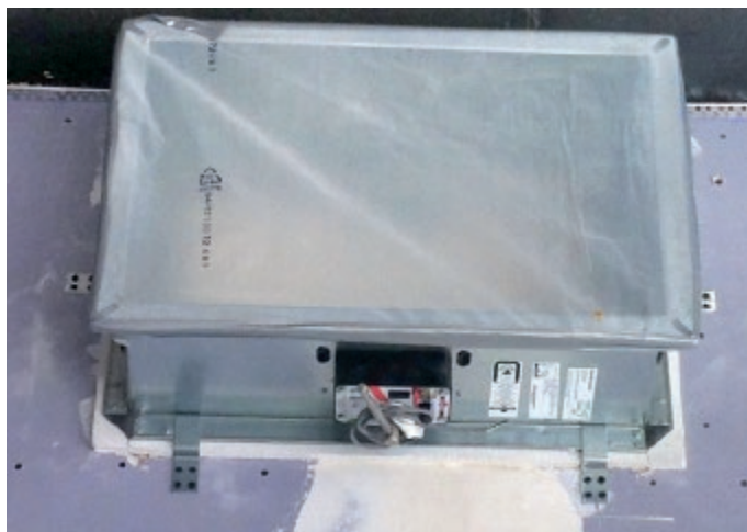
Die wartungsfreien Brandschutzklappen gewährleisten eine Feuerwiderstandsdauer von 90 Minuten.
