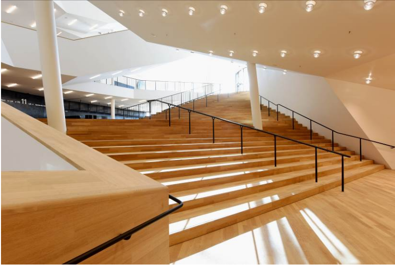
In den Treppenhäusern des Konzerthauses kommen Entrauchungsklappen des Typs EK90 zum Einsatz. (Foto: Michael Zapf)
